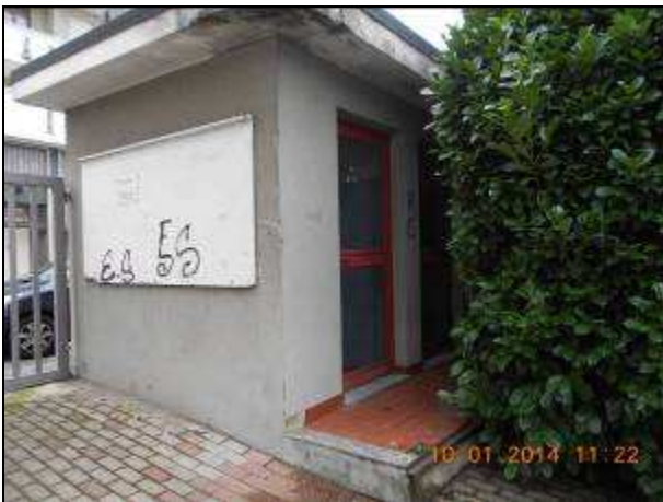
Servizi igienici esterni
