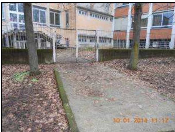
Uscita di sicurezza scuola media verso l'area sportiva
