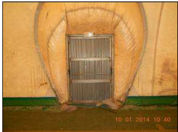
Particolare uscita di sicurezza
